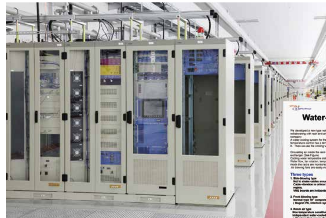
直線約700mにもおよぶ加速器棟に設置された水冷ラック
